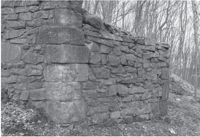
Abb. 6: Südöstlicher Eckverband des oberen Podiums, zusammengesetzt aus Werksteinen aus Basalttuff [Foto Stefan King]
