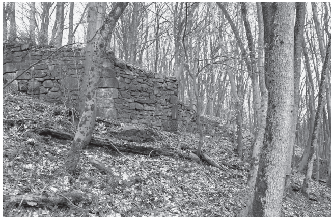
Abb. 2: Aufnahmen aus östlicher Richtung: oben von G. Ewald, um 1910 [aus: HOLTMEYER: Bau- und Kunstdenkmäler (wie Anm. 1), Tafel 176, Abb. 1], unten zum Vergleich der aktuelle Zustand vom selben Standpunkt [Foto Stefan King]
